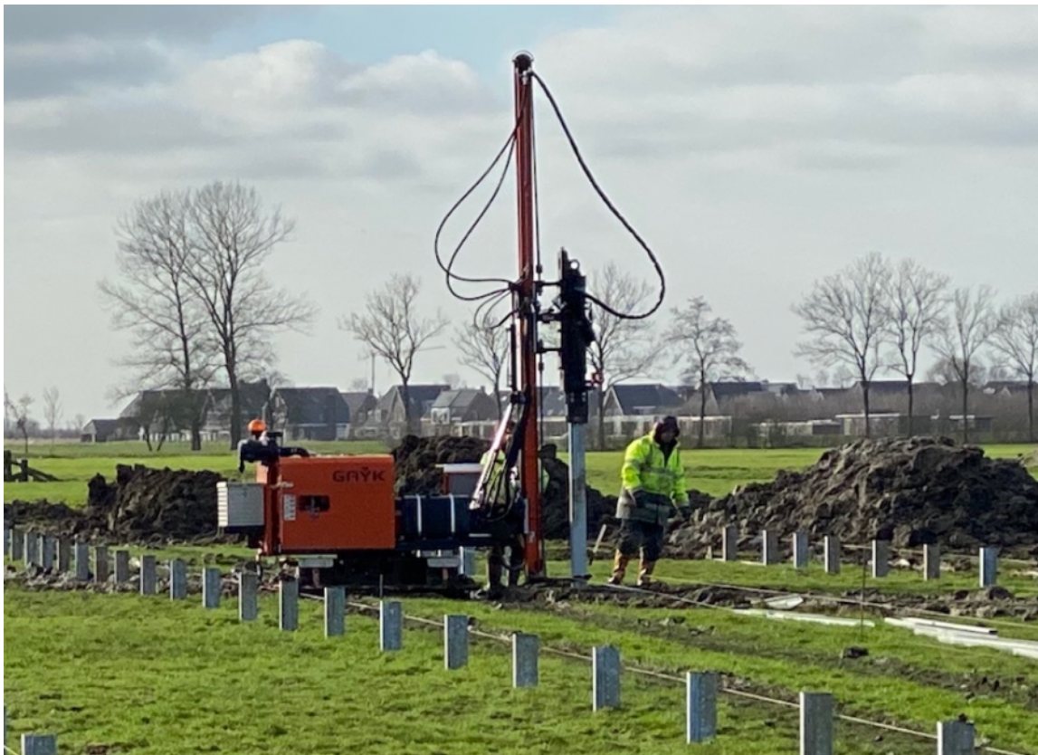
Figur 3-3 Eksempel på pælemaskin for fundamenter fra konstruksjonen av Energeias solkraftverk i Nederland.
