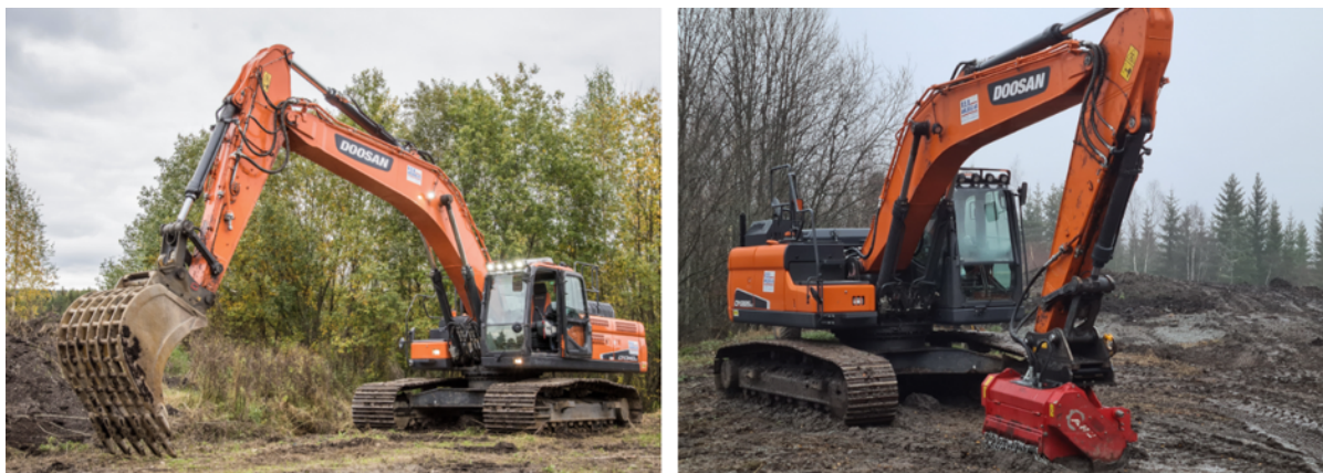
Figur 4-1 Anleggsmaskiner i arbeid med flateplanering for nydyrking, kilde REB anlegg AS.
