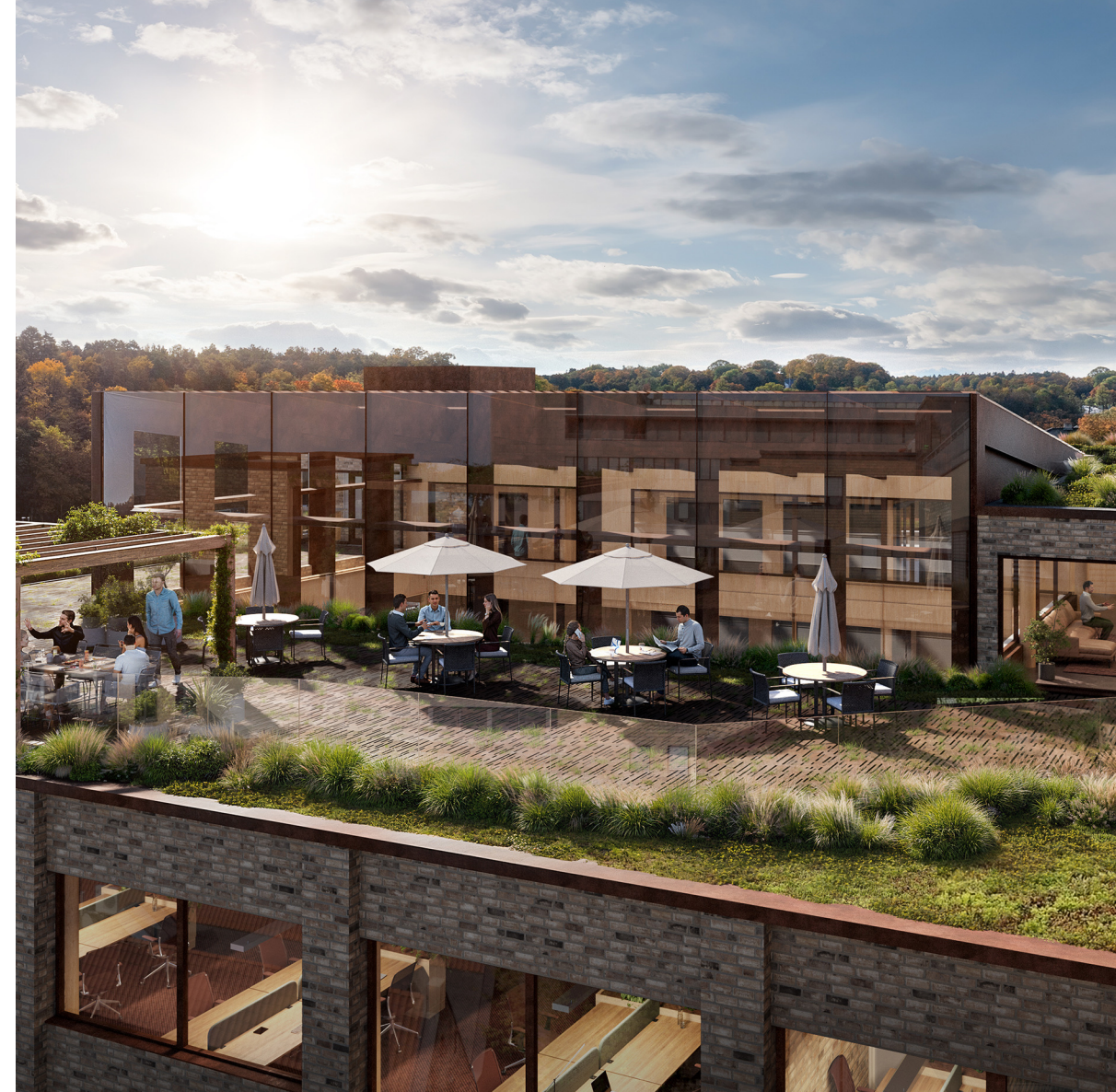
Karenslyst Alle no 24, Oslo | Photo: Plyo - LINK Arkitektur
