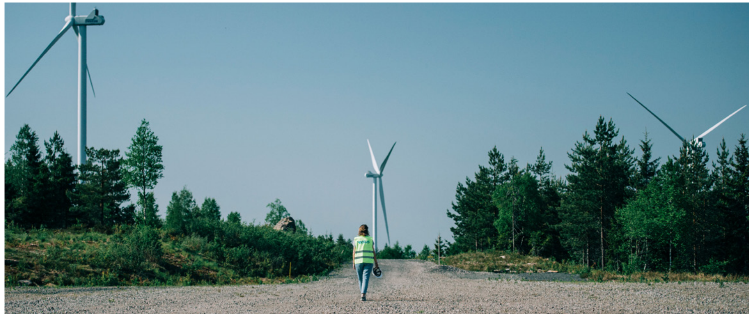
Vindpark Sötterfällan i Småland.
