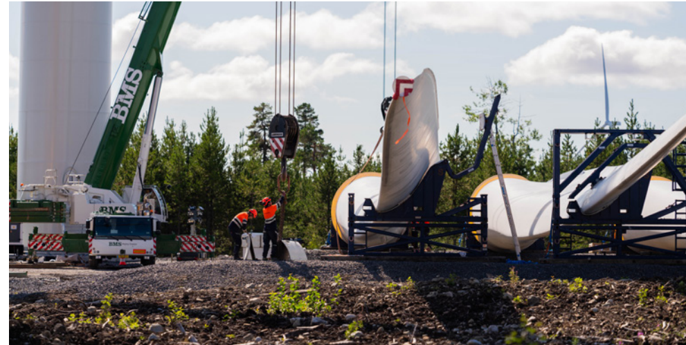
Arbetstagare i Eolus värdekedja arbetar bland annat med tillverkning, montering och byggnation av anläggningar.
