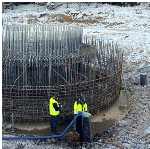
Gjutning av fundament till ett vindkraftverk.
