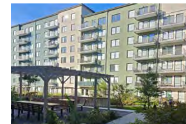
Brygghuset, Ursvik Sundbyberg, 381 hyresrätter, en förskola samt lokaler, köpare Heimstaden Bostad
