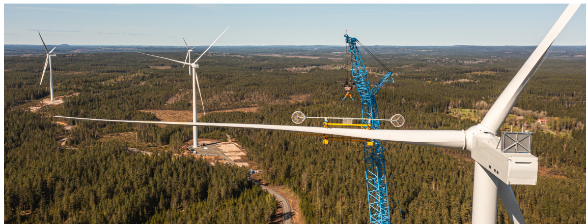
Vindprojektet Boarp byggs i Vaggeryds kommun i elprisområde SE3 och omfattar 25 MW.
