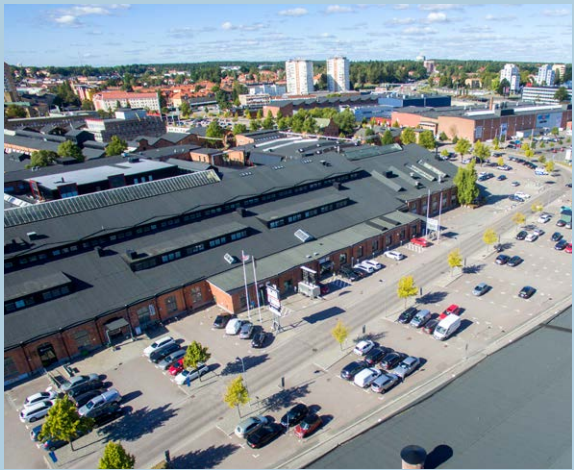
Kontorsfastigheten Verkstaden 6 i Västerås.
