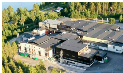
NorthX Biologics anläggning i Matfors.
