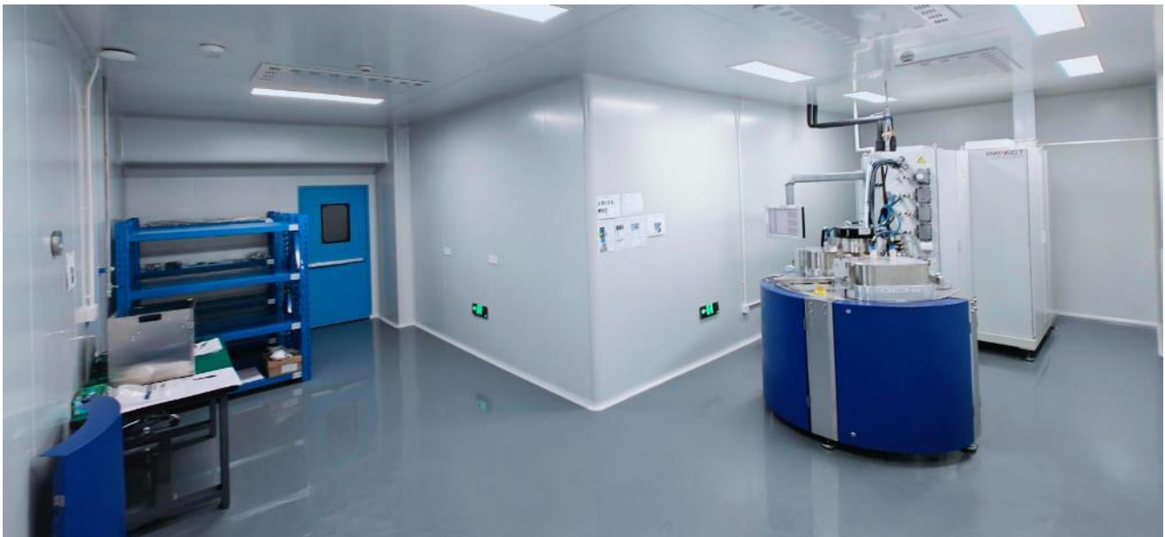
Beläggningssystemet som överförts från Sverige installerat i Coating Service Center China, för beläggning av vågledarantenner åt Waveland Technology.
