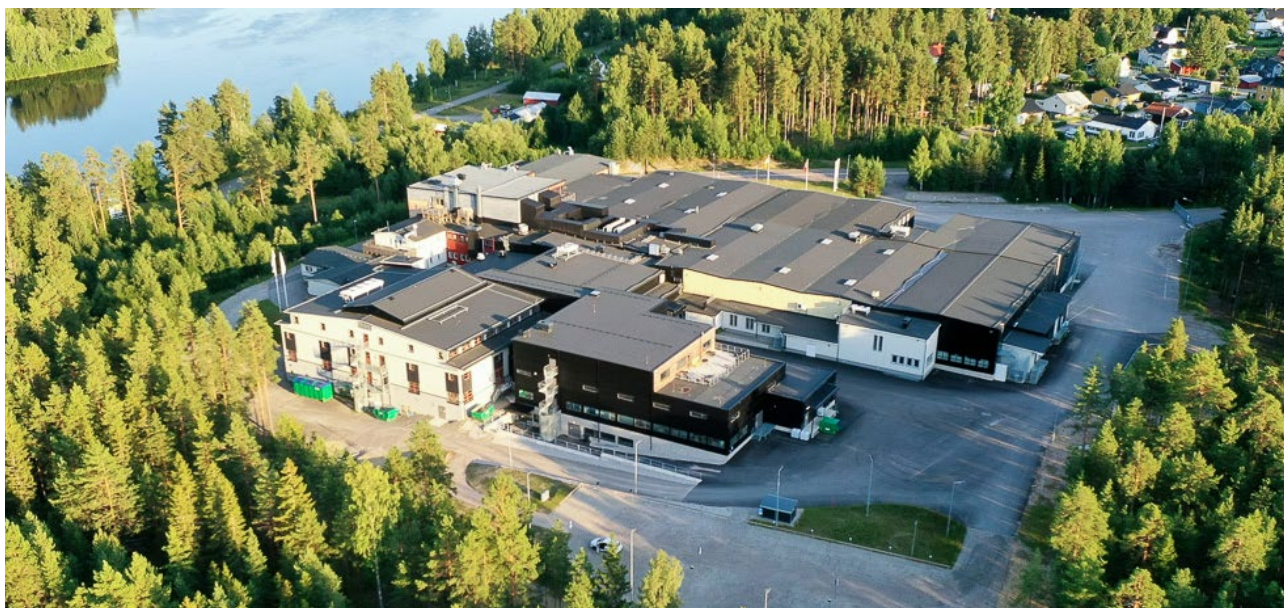
NorthX Biologics anläggning i Matfors.
