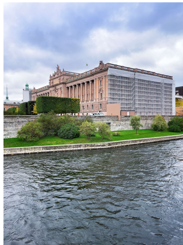
Riksdagshuset, sätet för Sveriges riksdag i Stockholm, är täckt med 1000m 2 HAKI-ställning. HAKI bistår i detta projekt en stor kund, som fått det ärofyllda specialistuppdraget att leverera säkra lösningar i samband med renovering av Riksdagshuset - och dessutom Storkyrkan som skymtas i bakgrunden.
