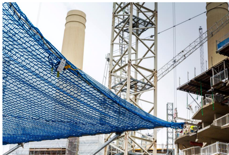
Battersea Power Station, England, med Vertemax skyddsnät.
