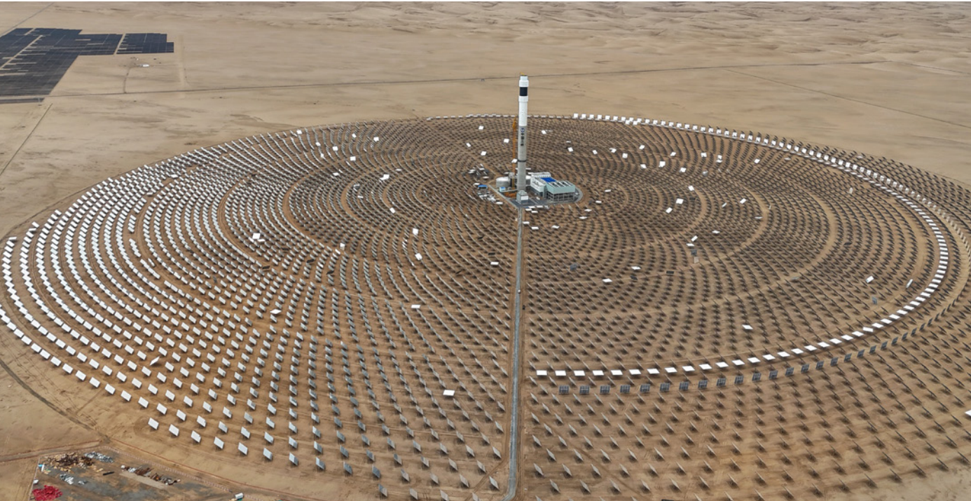
Ett projekt för solenergi från smält salt i ett solkraftstorn i öknen i nordvästra Kina. Alimaks industrihiss SL500 installerades i tornet där solljuset reflekteras i cirka 2 000 speglar och smälter saltet högst upp i tornet för att alstra elektricitet.
