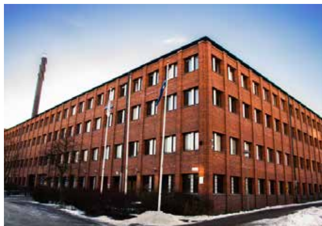
Vincero Fastigheters fastighet på Instrumentvägen 29-31 i Stockholm består av kontor och lagerlokaler.
