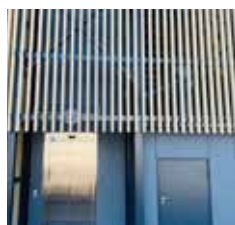
Underhållsfria fasader med träinslag.
