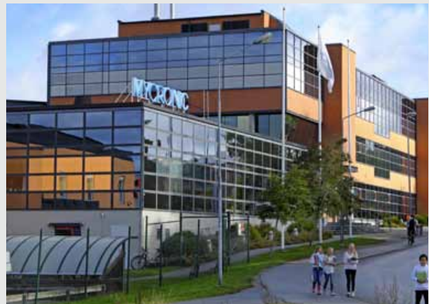
Mycronics produktionsanläggning i Täby utanför Stockholm. Här har flera projekt genomförts för att minska miljöpåverkan. Exempelvis har bergvärme installerats och det pågår utbyte av ljuskällor till LED.
