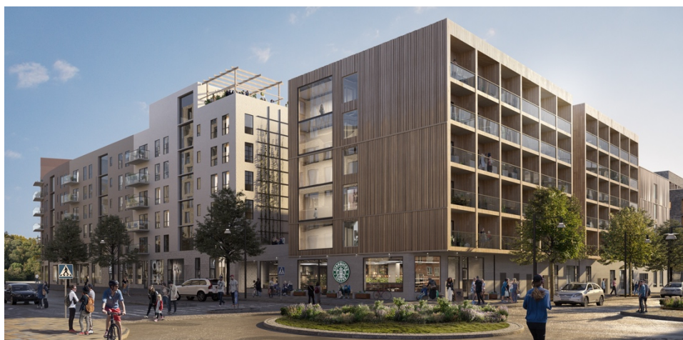
K2A var en av vinnarna i Järfälla kommuns markanvisningstävling och kommer att utveckla 200 bostäder i Barkarbystaden i anslutning till den nya tunnelbanestationen.
