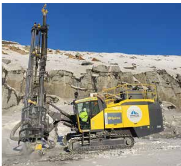
En av Norrbottens Bergtekniks nya D65 XLF-riggar från Epiroc under arbete i Aitikgruvan
