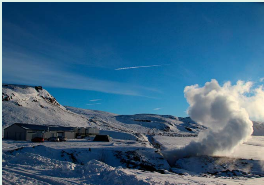
Ungefär ett år efter att förstudien påbörjades förser nu Varmaorkas första geotermiska kraftverk omringliggande samhälle med lokalt producerad förnybar el.
