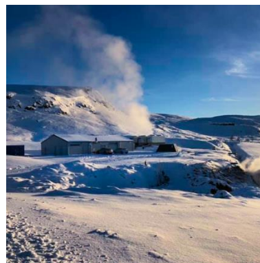
Varmaorka sluttestar nu sitt första geotermiska värmekraftverk, inklusive Climeons Heat Power-moduler.
