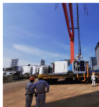
I juli påbörjades integrationen av Heat Power-moduler ombord på Viking Lines nya fartyg, Viking Glory.
