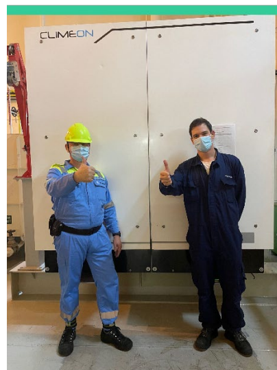
Ovan: Climeons personal vid installation av modul ombord på Maersks fartyg.
