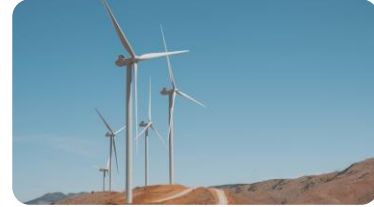
Byggnation av vindpark Wind Wall i Kalifornien, USA.
