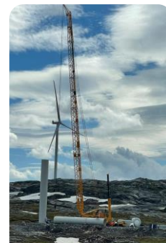
Montage av vindkraftverk i vindpark Øyfjellet i Vefsn kommun i Norge.
