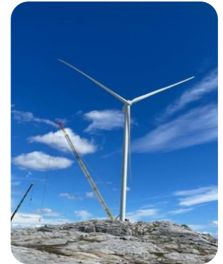
Montage av vindkraftverk i vindpark Öyfjellet i Vefsn kommun i Norge.
