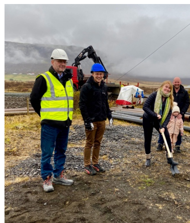
Byggnationen av Varmaorka och Climeons tredje kraftverk har påbörjats.
