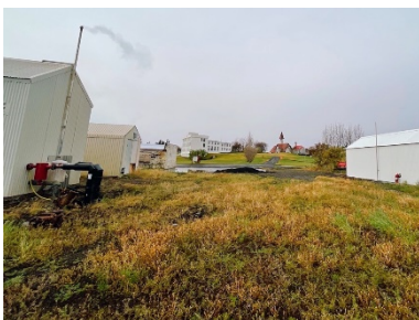
Varmaorkas kraft- och fjärrvärmeverk, Reykholt, Island.
