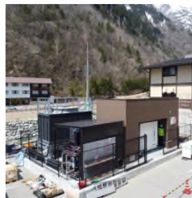
I Japan pågår installationsarbetet vid två olika kraftverk, varav ett driftsattes i slutet av april.
