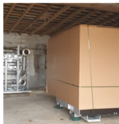
I Reykholt på Island har Climeon påbörjat installationen av Heat Power-systemen samt bolagets prototyp för standardiserade rörledning, Backbone.
