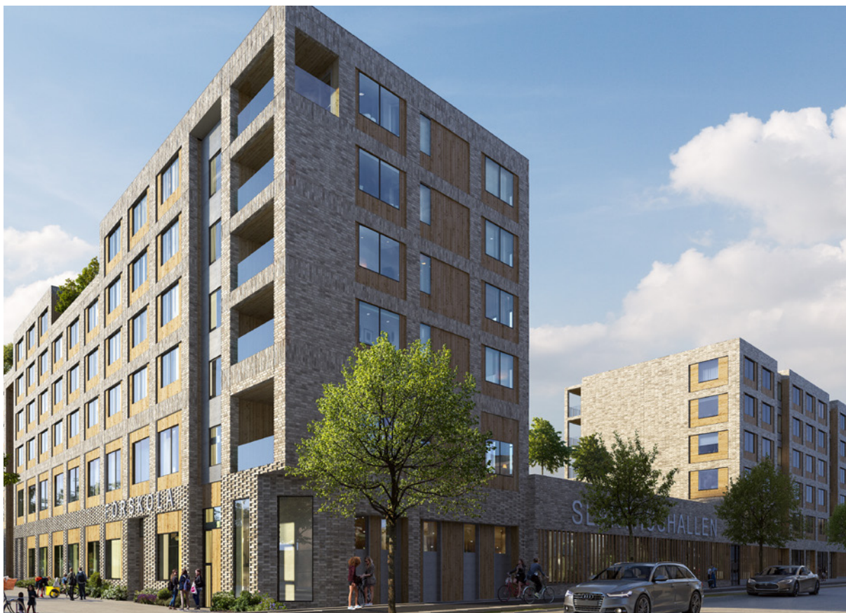
I juni 2022 godkände Stockholms stad hyres- och exploateringsavtalet för en idrottshall med en yta om 2 300 kvm i Slakthusområdet i Stockholm. Byggstart planeras till det första kvartalet 2024.
