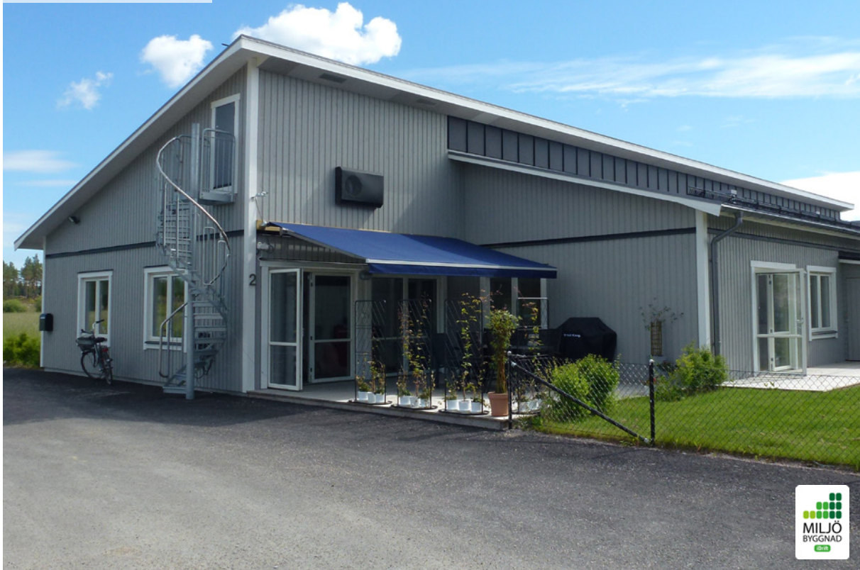
1 LSS Uppsala Färdigställt 2014
