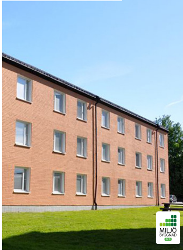
2 Bottenhavet 21 Ombyggnation färdigställd 2021
