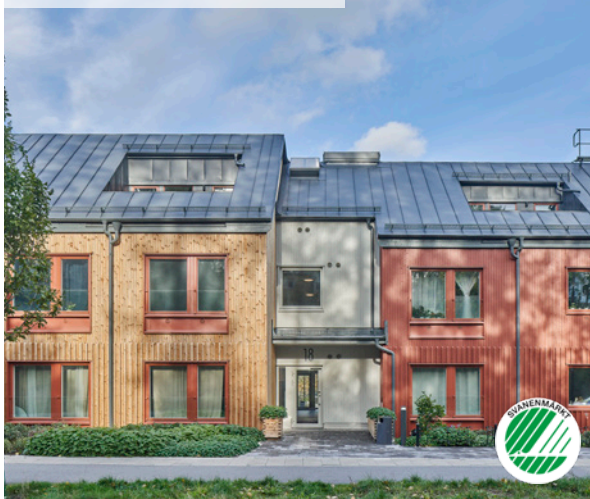
3 Vega park, etapp 3, Haninge Färdigställt 2019/2020
