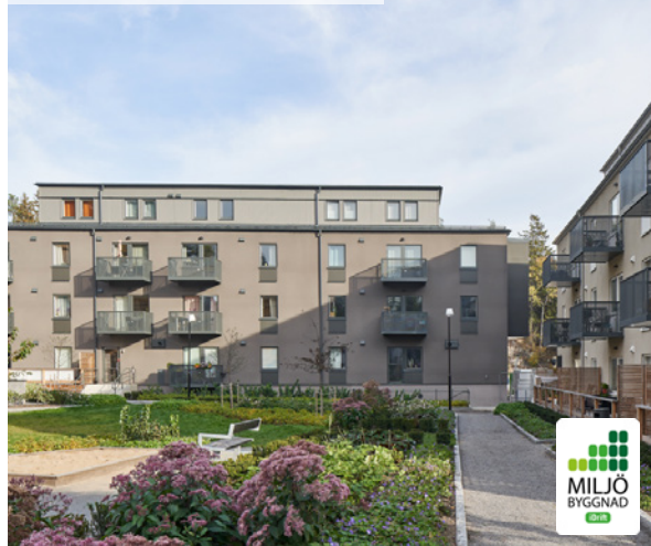
2 Vega park, etapp 2, Haninge Färdigställt 2018
