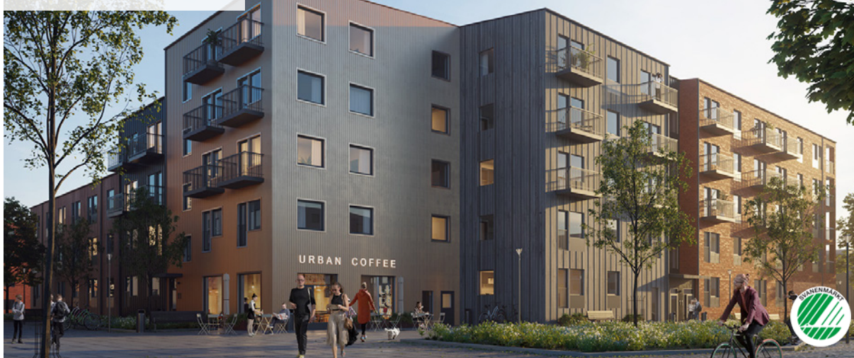
6 Brynäs 19:18, Godisfabriken Färdigställt 2021
