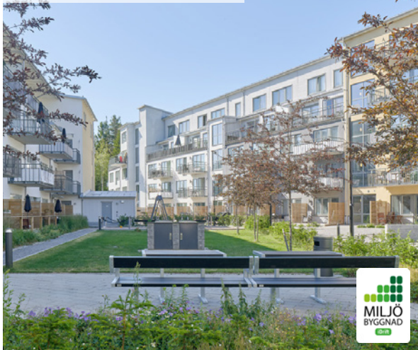
1 Vega park, etapp 1, Haninge Färdigställt 2016
