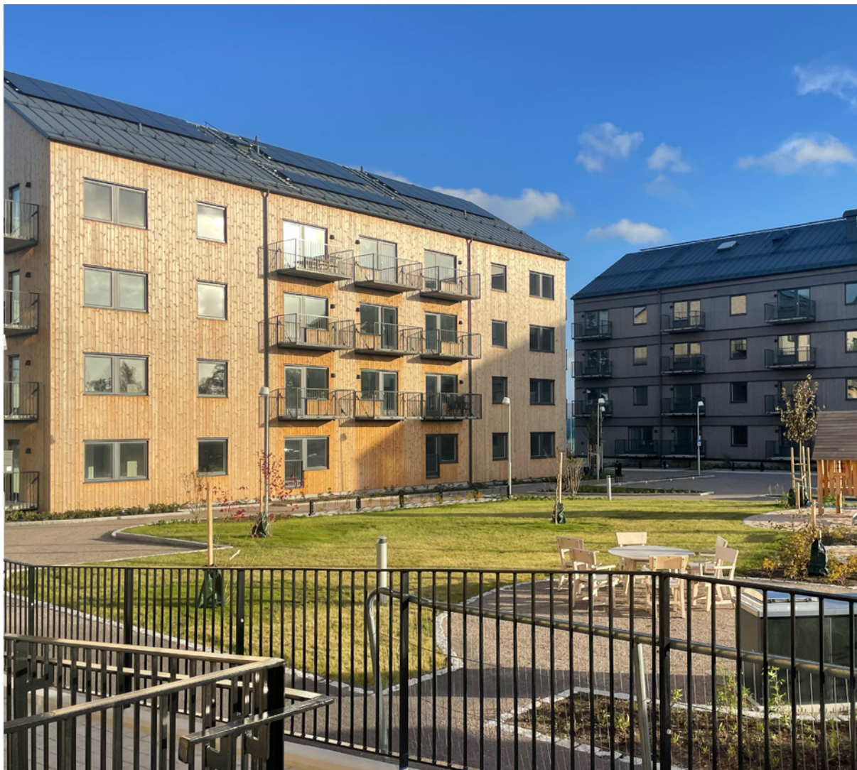
I livfulla Arenastaden, beläget cirka 2 kilometer väster om Växjö centralstation har K2A byggt 185 Svanenmärkta hyresbostäder. Husen färdigställdes och flyttades in under det tredje kvartalet 2023.
