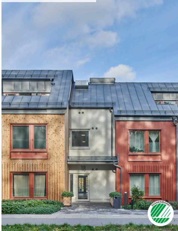
Vega park, etapp 3, Haninge Färdigställt 2019/2020
