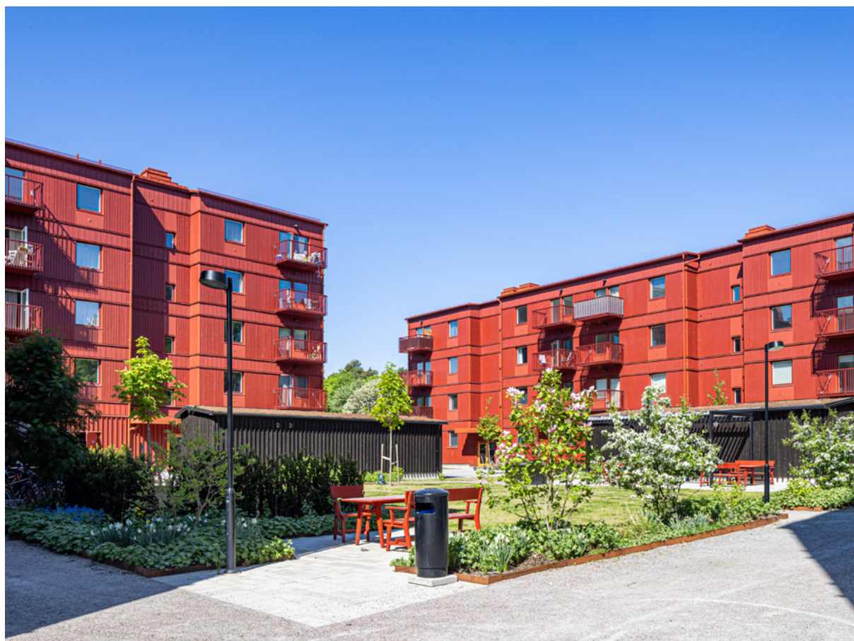
Galaxen i Västerås, färdigställd första kvartalet 2023, rymmer 155 hyresbostäder. Fastigheten är byggd av svenskt certifierat trä och miljöcertifierad enligt Svanen.
