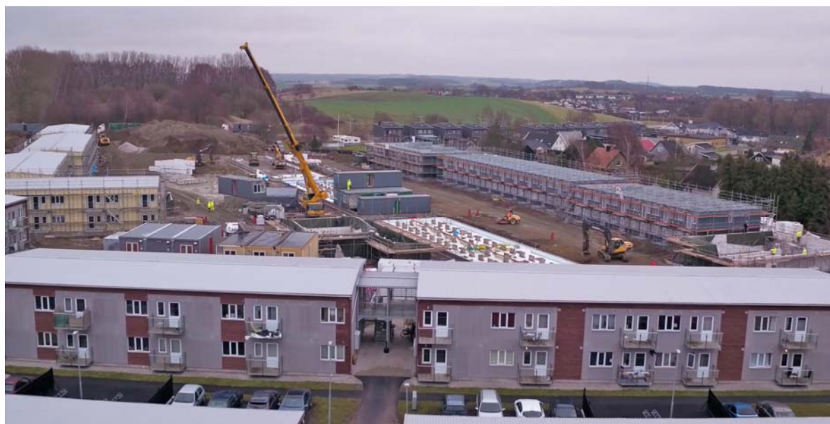
Byggnation på Malmö Träpanelen 1, färdigställda lägenheter på Träpanelen 8 i förgrunden
