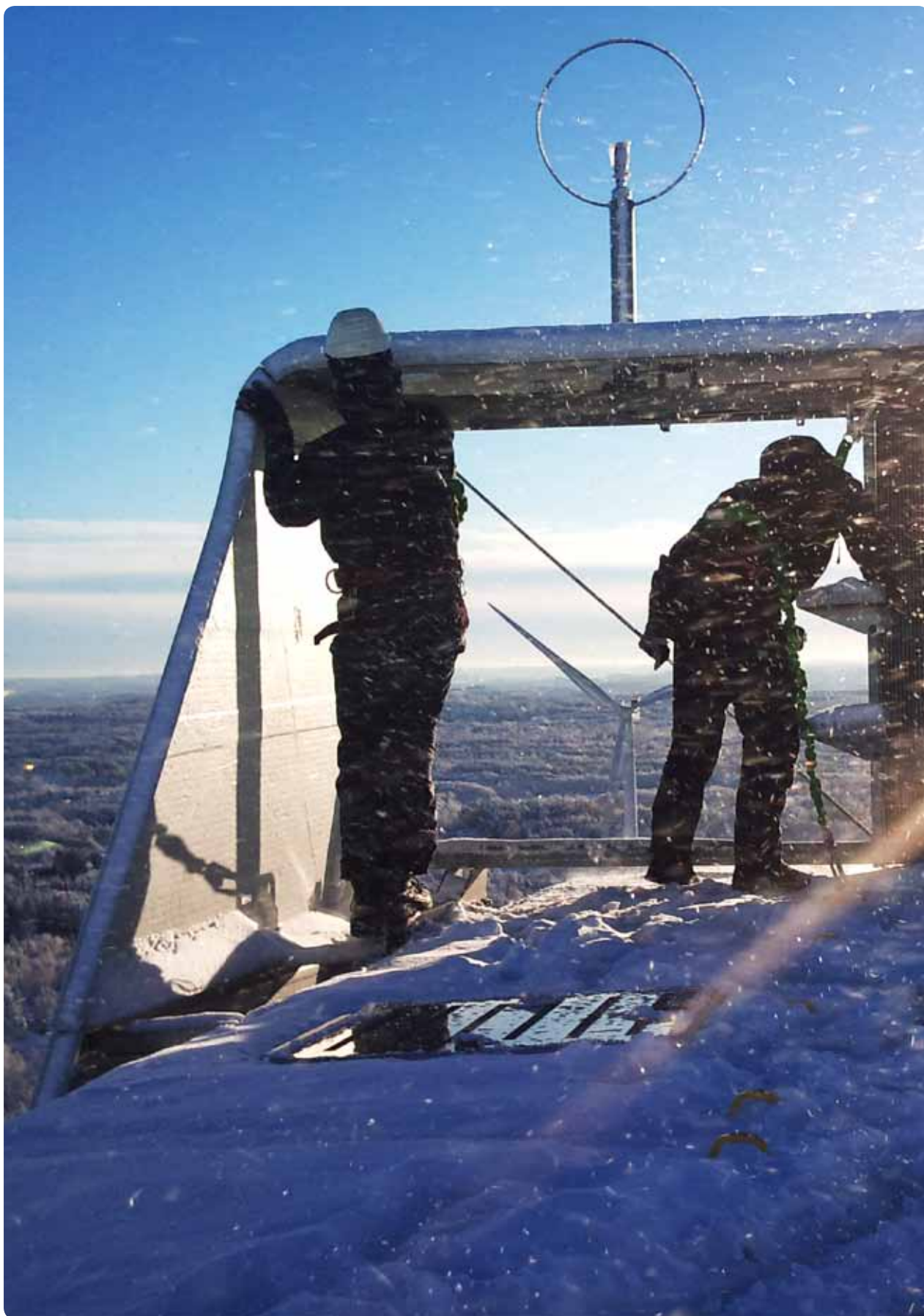
Erikstad, Melleruds kommun, sex Vestas V90 2,0 MW verk uppförda under november 2010. Total beräknad produktion för parken uppgår till 32,1 GWh miljövänlig el.
