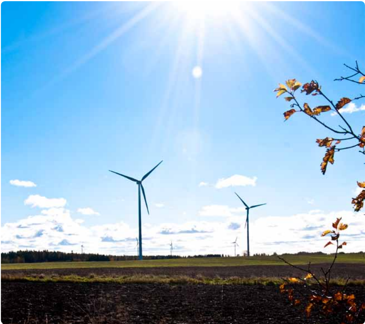
Lårstad, Motala Kommun, fyra Vestas V90-2,0 MW med 105 m navhöjd etablerades våren 2010.
