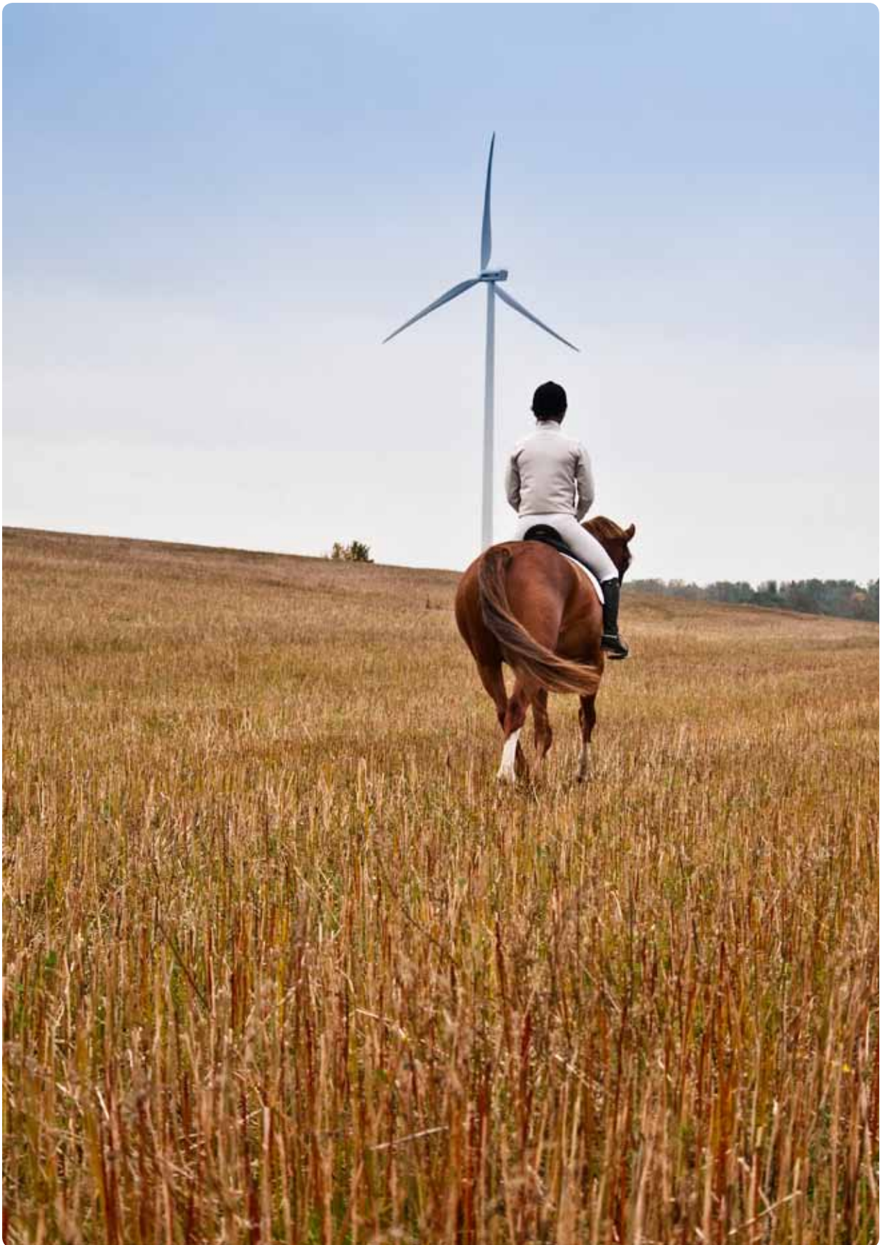
Vid Källeberg och Backgården i Falköping kommun har Eolus etablerat sju Vestas V90 2,0 MW verk sommaren 2010.
