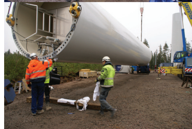
Byggnation vid Fågelås and Skara
