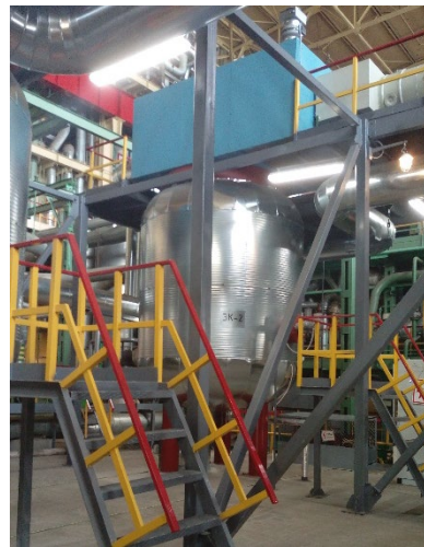
Hetvattenpanna för miljövänlig fjärrvärme.
