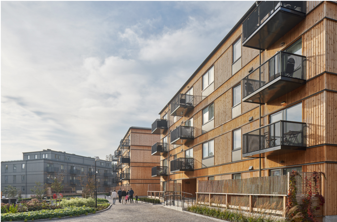
K2A:s hyresbostäder i Vega Park i Haninge. K2A utvecklar den tredje och sista etappen. Fotot avser hyresbostäder uppförda i etapp 2 med varierande exteriör utformning med rymlig och inkluderande innegård.
