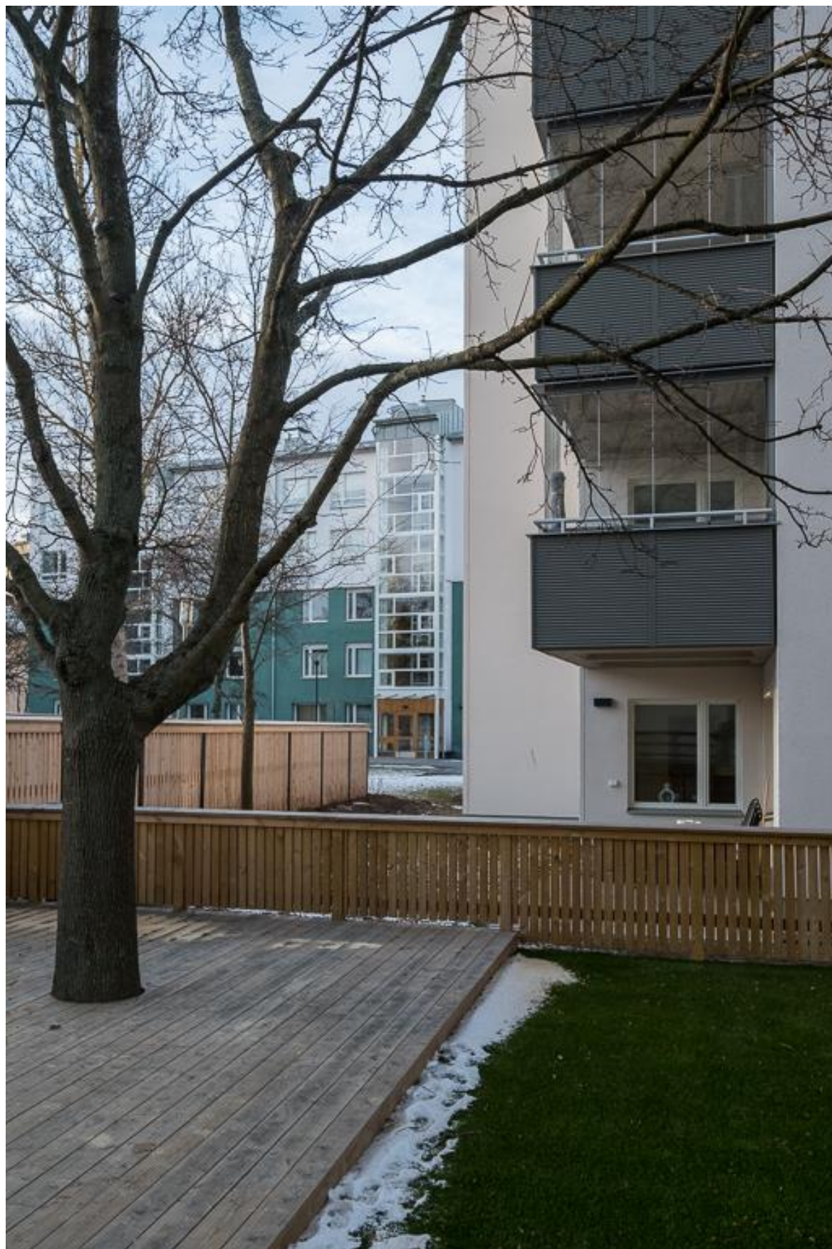
Kv. Hedvig i Spånga
