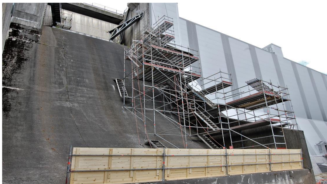
Ställningsbygge uppfört av JUF Byggnadsställningar AB på Ramsele kraftstation.
