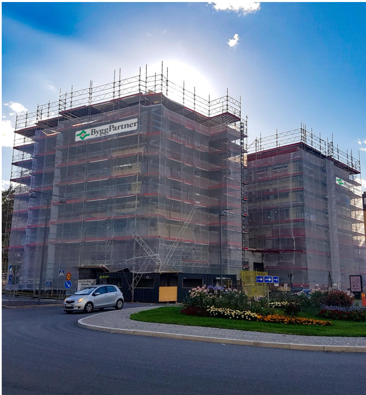
Tule Plaza, ett projekt åt Vectura Fastigheter AB i Sundbyberg
