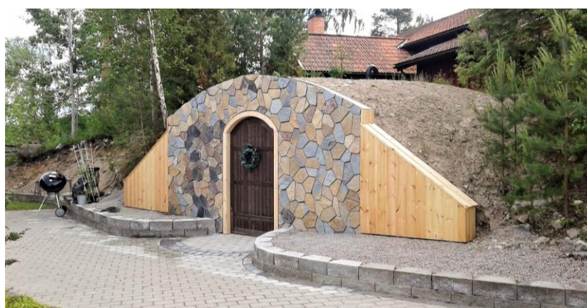
Jordkällare byggd av ByggPartner i Dalarna Service AB i Hedemora.
