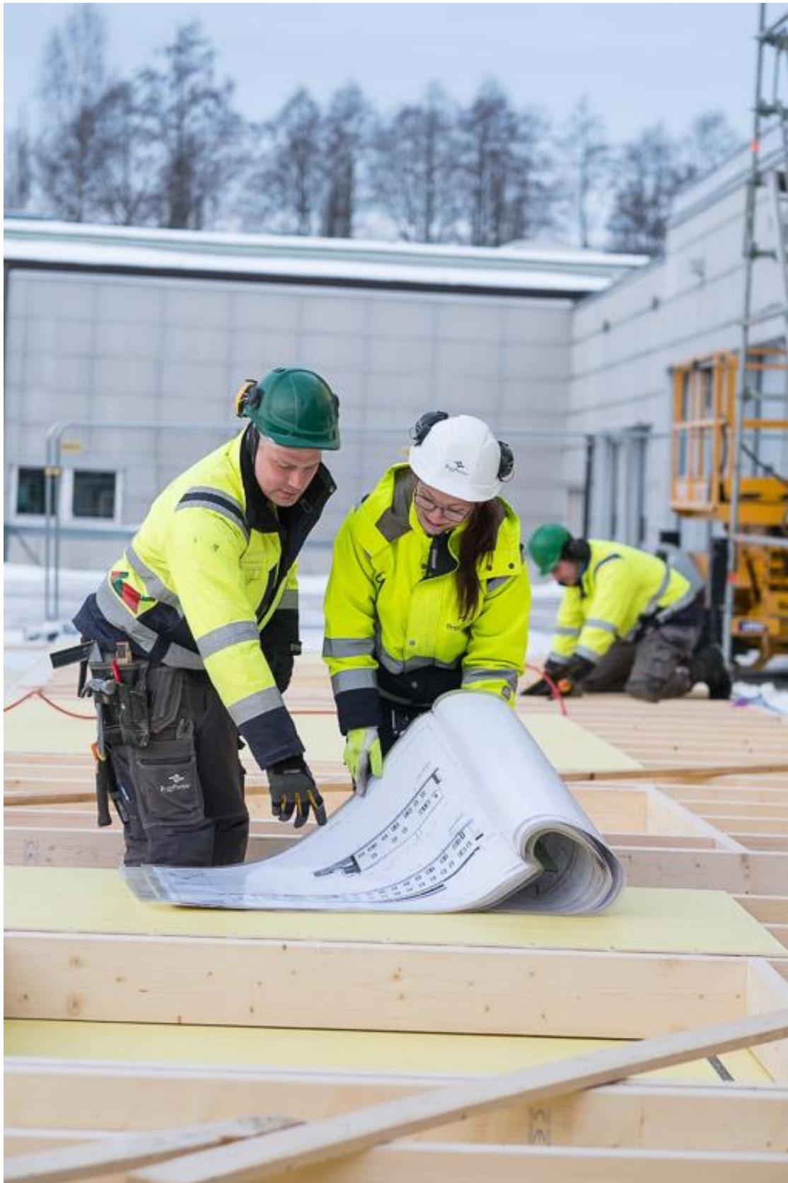
LD-hjälpmedelscentral i Borlänge, ett projekt åt Landstinget Dalarna
