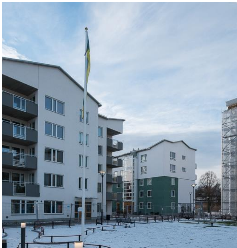
Kv Hedvig i Spånga
