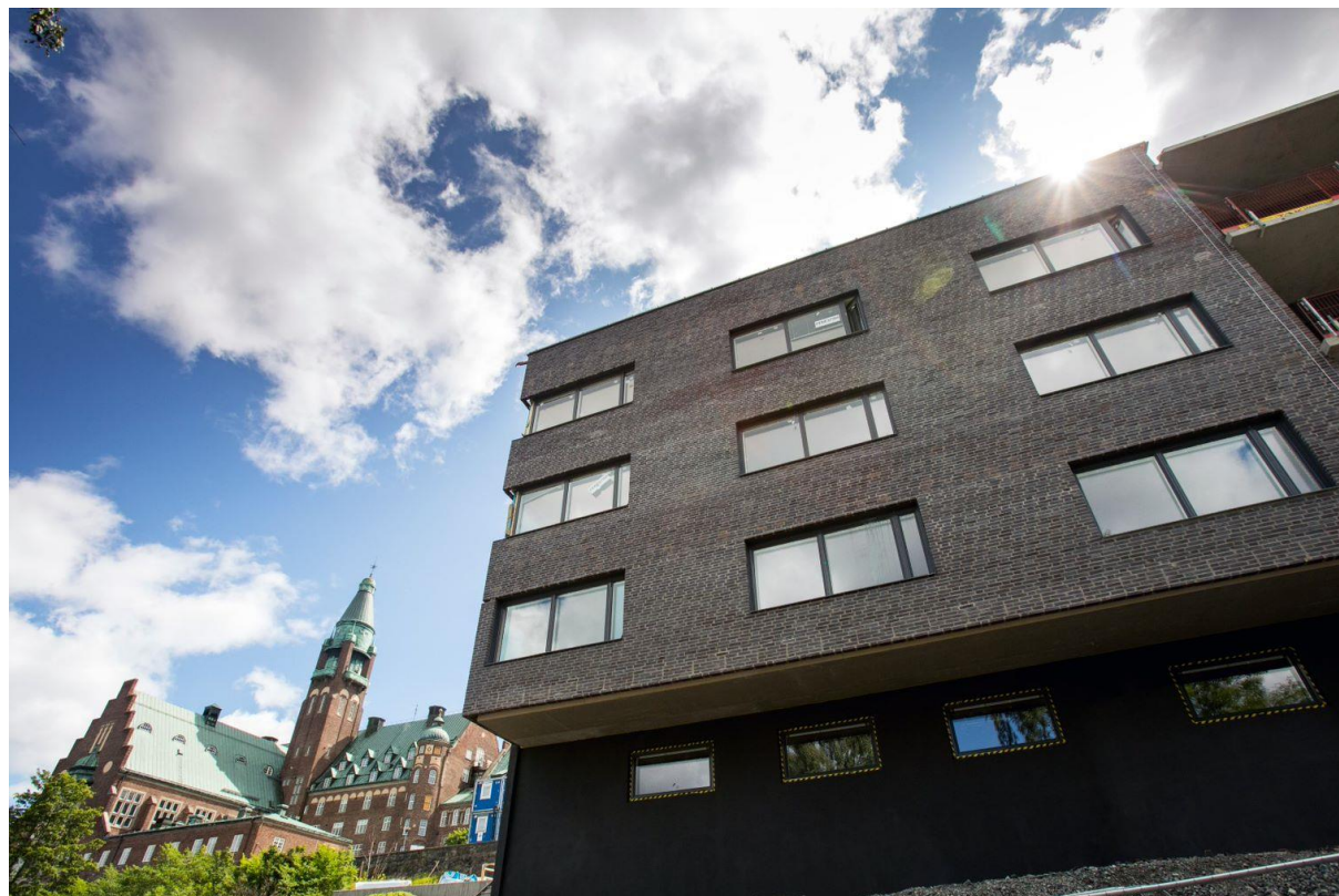
Nytt vårdboende som ByggPartner byggt åt Stiftelsen Danviks Hospital i Nacka, Stockholm.
