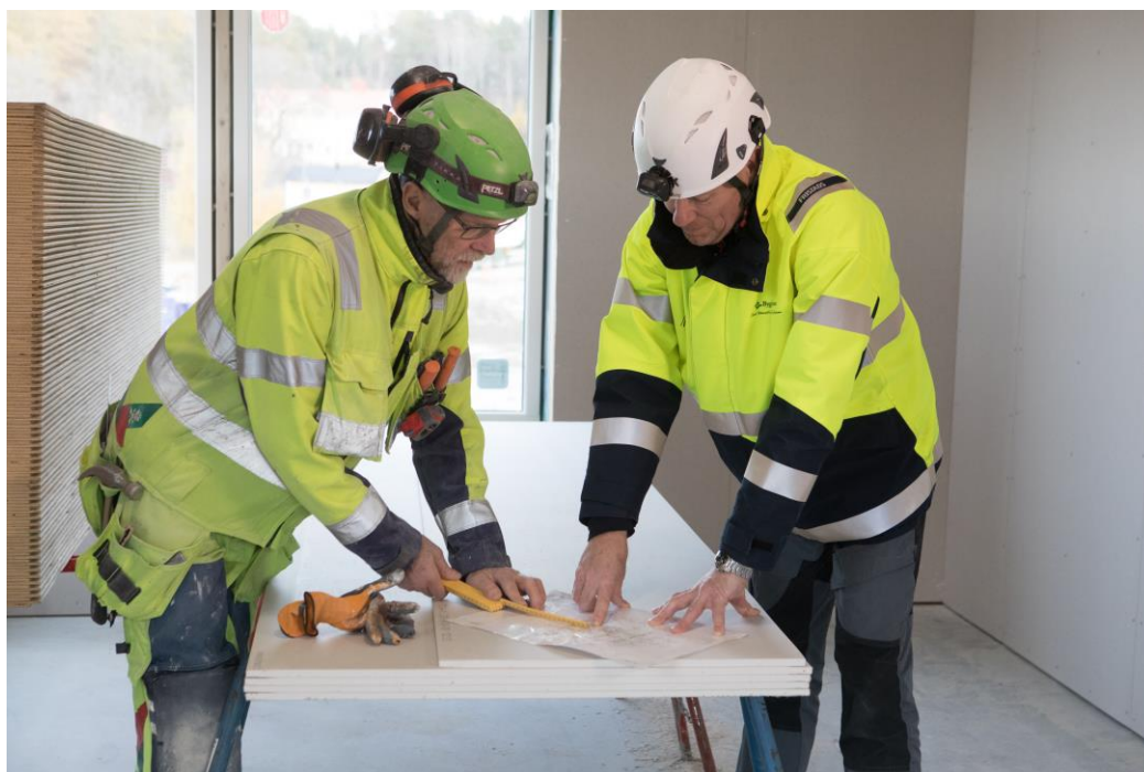
Projektet Vattenspegeln där ByggPartner bygger förskolan Skogsglántan åt Arboga kommun.
