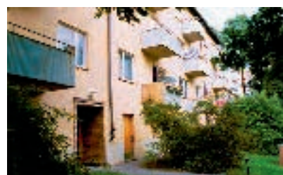
Spikvägen 49–53/Tångvägen 44–46, Antennen 5, Västberga.
