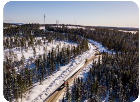
Vindpark Jenåsen i Sundsvalls kommun.
