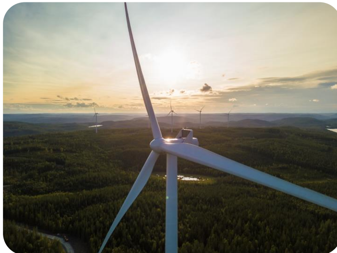
Vindpark Jenåsen i Sundsvalls kommun.
